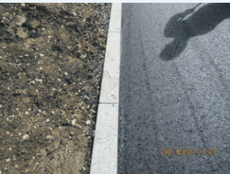
Granitbordstein gesägt und gestockt mit Fasse
