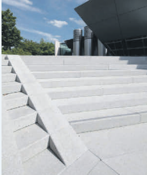
Treppenanlage mit Rampenelementen und Signalstreifen
