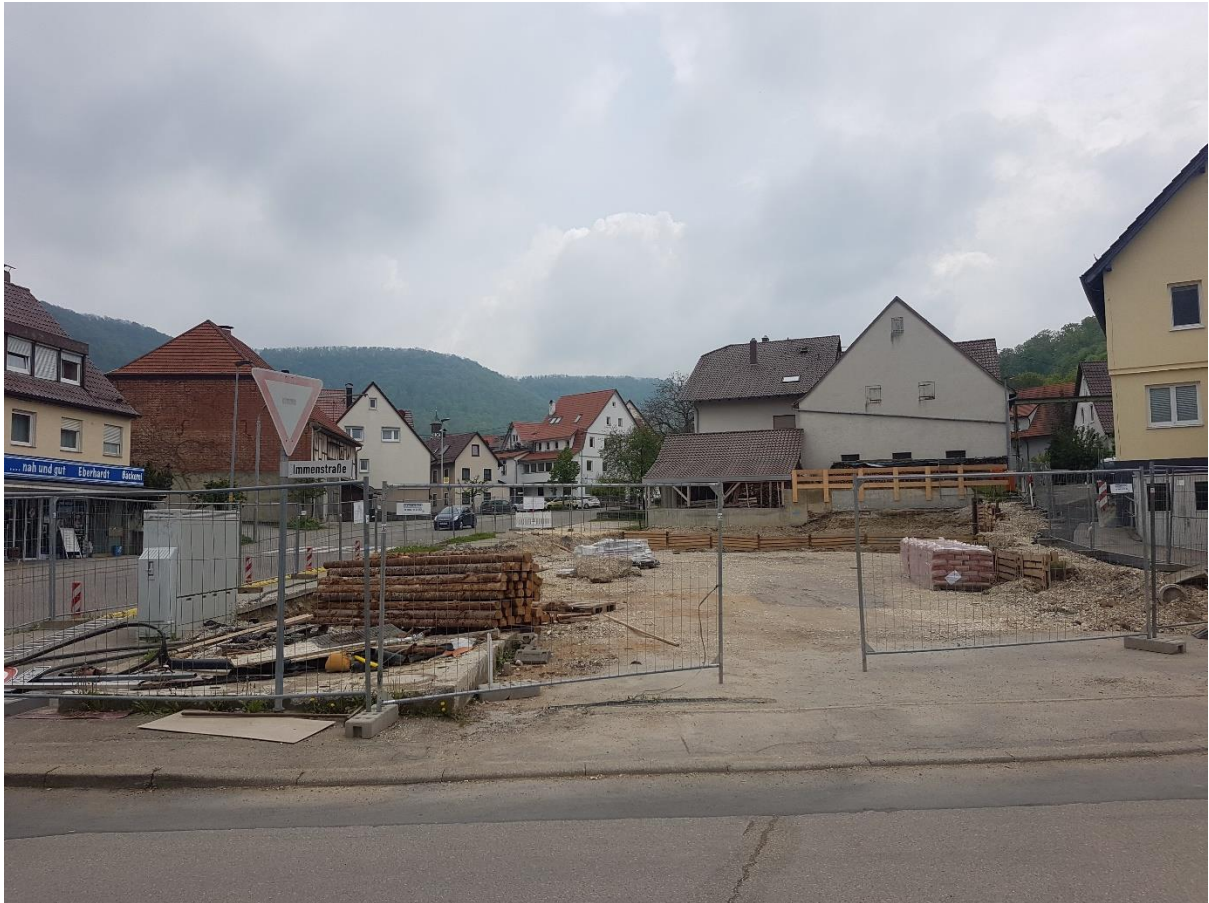
Bild Baustelle „Betreutes Wohnen“
